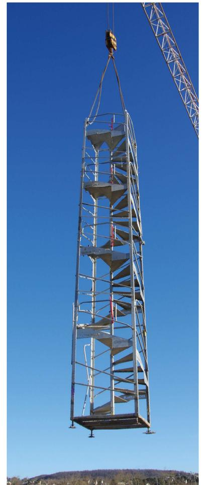
Levage à la grue d'un Escalib Mills.
