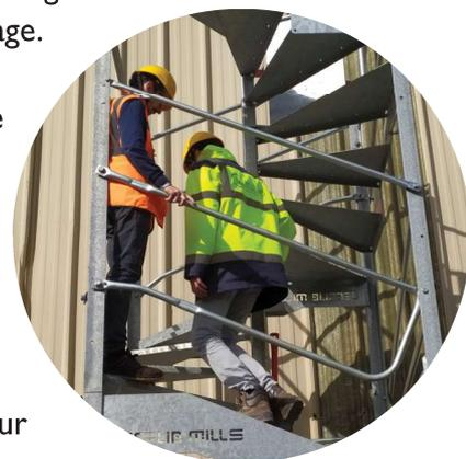
L'Escalib Mills est déplaçable à la grue (8 modules maxi.). Son faible encombrement facilite son installation. Le Mini Escalib Mills (1m28x1m28) est conçu pour les chantiers les plus exigus. Des plateformes et des passerelles complètent la gamme pour suspendre des Escalib Mills ou pour franchir des obstacles.
