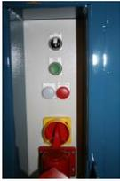
Chauffage soufflant pour la protection de l'armoire technique
